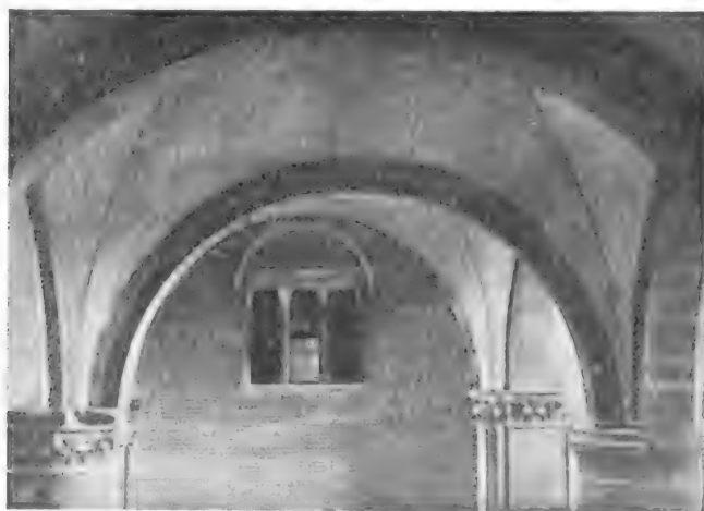
Trifora con architrave nella trasversa.
